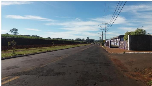
FOTO 07 – CONTINUAÇÃO TRECHO 02 – AVENIDA PRESIDENTE CAMPOS SALLES SAÍDA SABÁUDIA/ARAPONGAS.
