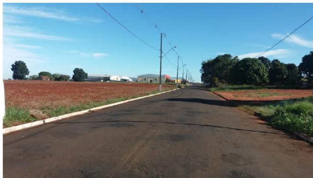
FOTO 01 – INÍCIO TRECHO 01 – AVENIDA PRESIDENTE CAMPOS SALLES SAÍDA SABÁUDIA/ASTORGA.
