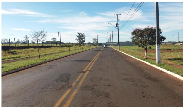
FOTO 06 – CONTINUAÇÃO TRECHO 02 – AVENIDA PRESIDENTE CAMPOS SALLES SAÍDA SABÁUDIA/ARAPONGAS.
