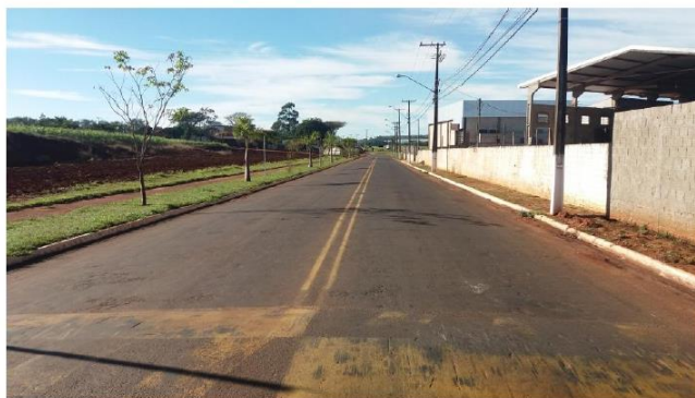
FOTO 08 – CONTINUAÇÃO TRECHO 02 – AVENIDA PRESIDENTE CAMPOS SALLES SAÍDA SABÁUDIA/ARAPONGAS.
